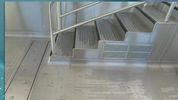
Einstieg öffentlich (mit Trittmarkierung und Handlauf)
