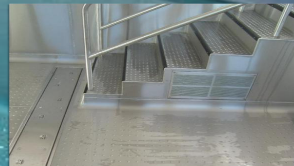
Einstieg öffentlich (mit Trittmarkierung und Handlauf)
