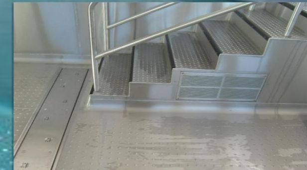
Einstieg öffentlich (mit Trittmarkierung und Handlauf)
